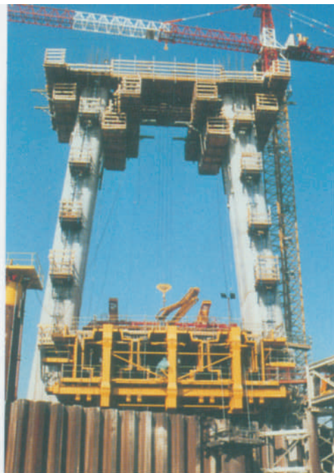
Sopra e nella pagina a fianco, vedute e particolari del completamento delle antenne di sostegno e dell'impalcato in cemento armato del nuovo ponte.
